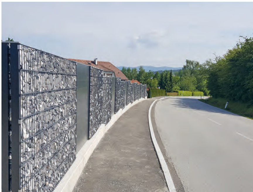
Steinzaun unterteilt mit Staketto 150 mm als Sichtschutz
